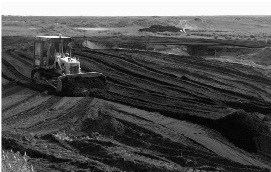
Frá framkvæmdum við nýja 2. braut á Þorláksvelli.
