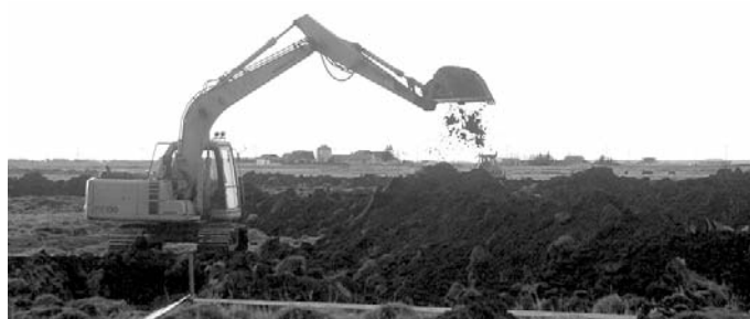
Framkvæmdir við nýtt tjaldsvæði í Björkurstykki við Selfoss.
