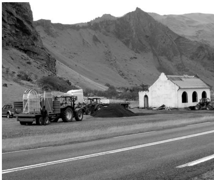
Unnið að endurbótum á húsinu Dagsbrún sem er í eigu félagsins.
