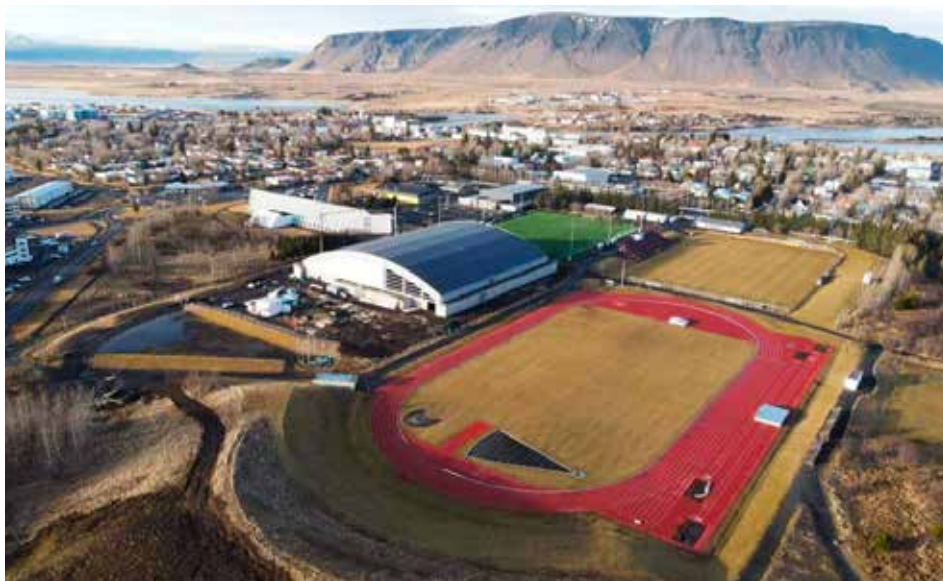
Séð yfir vallarsvæðið á Selfossi þar sem nýtt fjölnota íþróttahús er í byggingu og verður tekið í notkun á Unglingalandsmótinu.
